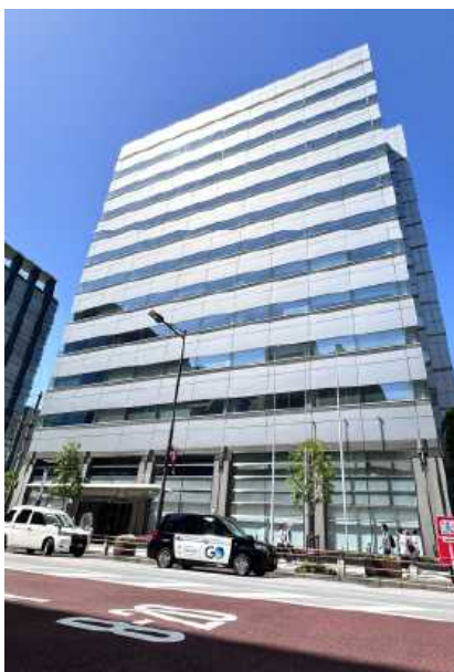
ビジョンセンターグランデ東京浜松町(外観)
